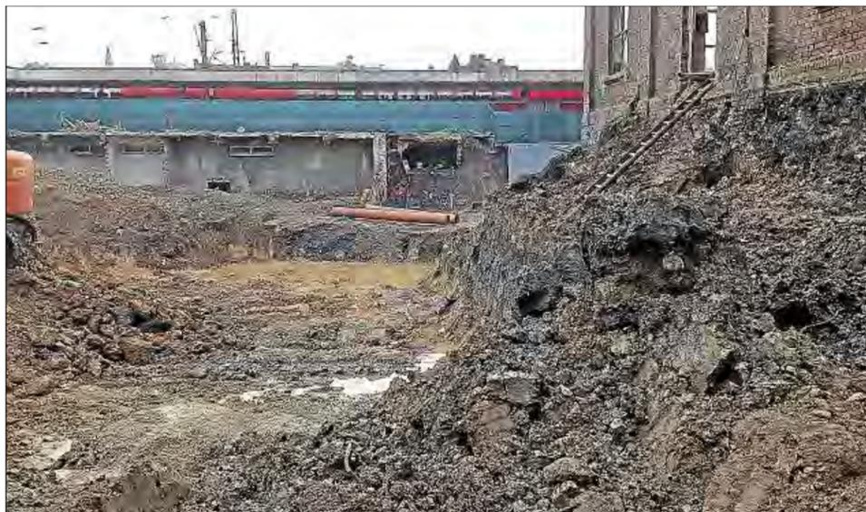
Schwierige Tiefbauarbeiten: Beim Bau der Tiefgarage war Maßarbeit angesagt. Die denkmalgeschützten Gebäude (rechter Bildrand) verfügen über kein Untergeschoss, und die Tiefgarage reicht bis nah an die Gleise (im Hintergrund des Fotos) heran. Foto: pr
